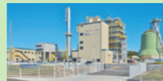
宮の郷木質バイオマス発電所 (茨城県常陸太田市)
