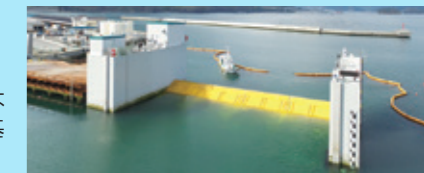
海底設置型のフラップゲート(岩手県)
