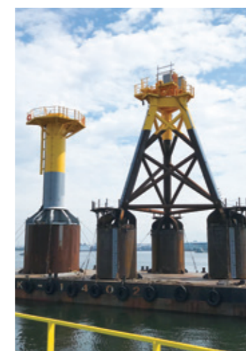
サクシオンバケット基礎(着床式) バケットと呼ばれる円筒形状をした海底に定着させる型式の基礎。バケット内の水をポンプにより排水することで海底に貫入させる。逆の手順でバケット内に注水することで撤去が可能。
