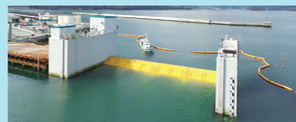
海底設置型のフラップゲート(岩手県)施工時全景
