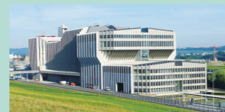
ごみ焼却発電施設 ルツェルン州ベルラン(スイス)
