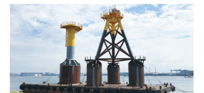
サクシオンバケット基礎(着床式) バケットと呼ばれる円筒形状をした海底に定着させる型式の基礎。バケット内の水をポンプにより排水することで海底に貫入させる。逆の手順でバケット内に注水することで撤去が可能。
