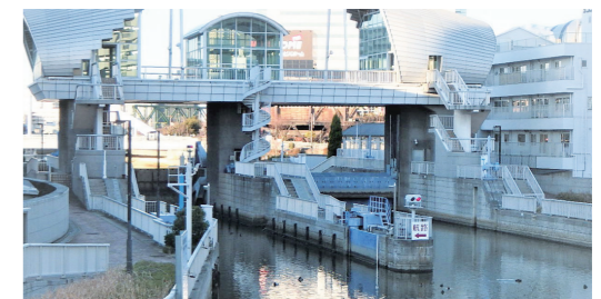
道頓堀川水門(大阪市)
