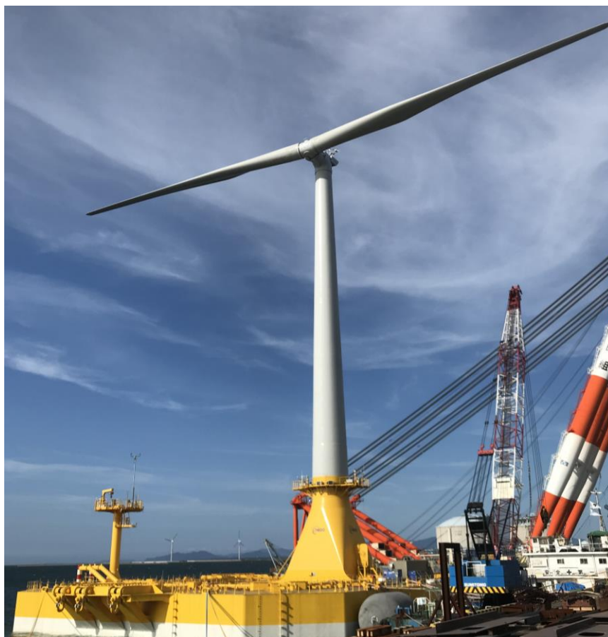
図1 バージ型浮体式洋上風力発電システム実証機
