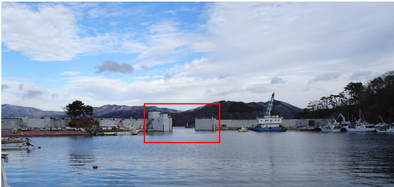
【岩手県 大船渡漁港海岸細浦地区での施工例（扉体は海底に倒伏）】
