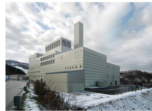
北しりべし広域クリーンセンター
