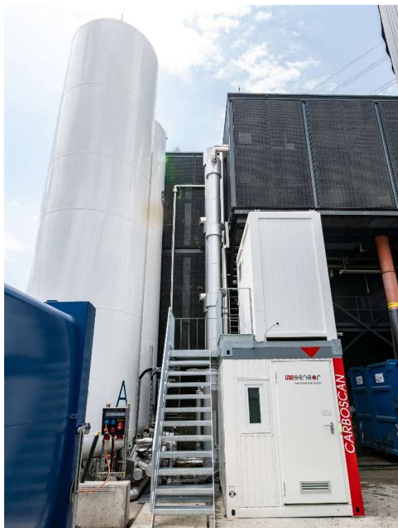
完工した CO 2 液化施設【© Regionalwerke AG Baden】
