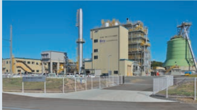
木質バイオマス発電所
