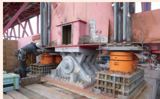
過去の別案件での橋梁補強工事の様子
