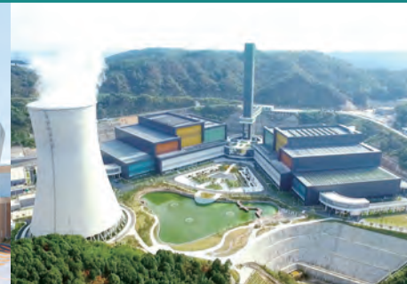
中国長沙市向けごみ焼却発電施設(1期)
