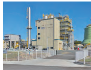
● バイオマスプラント
