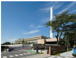
● ごみ焼却発電施設
