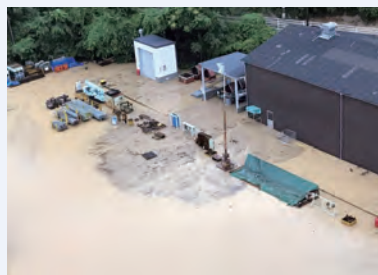
工場敷地内への土砂流入と浸水
