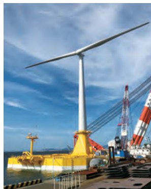
左: 洋上風力発電システムのバージ型浮体 (2018年6月、堺工場)
