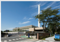
● ごみ焼却発電施設
