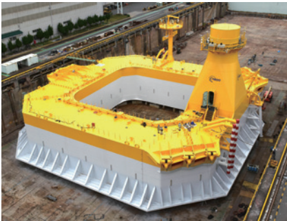
次世代浮体式洋上風力発電システムのバージ型浮体
