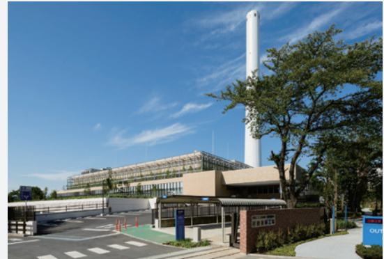
東京二十三区清掃一部事務組合 杉並清掃工場
