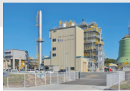
● バイオマスプラント
