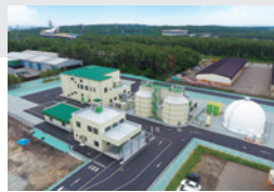
● バイオガスプラント
