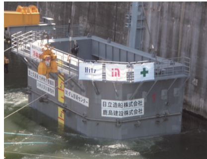
鶴田ダム(浮体式仮締切工法)
