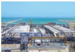
● 海水淡水化プラント
