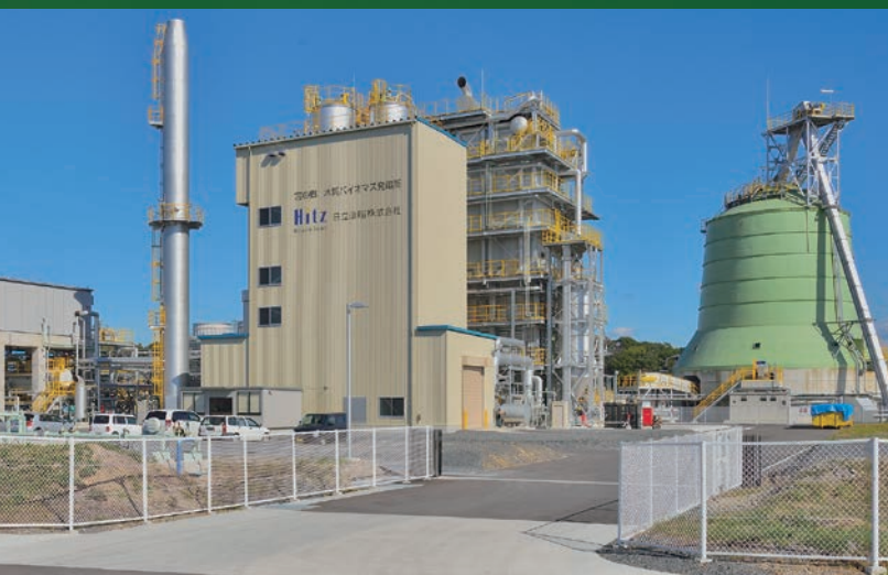
宮の郷木質バイオマス発電所（茨城県）
