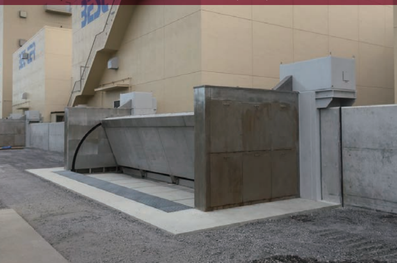
撫養港海岸陸閘ゲート(徳島県)
