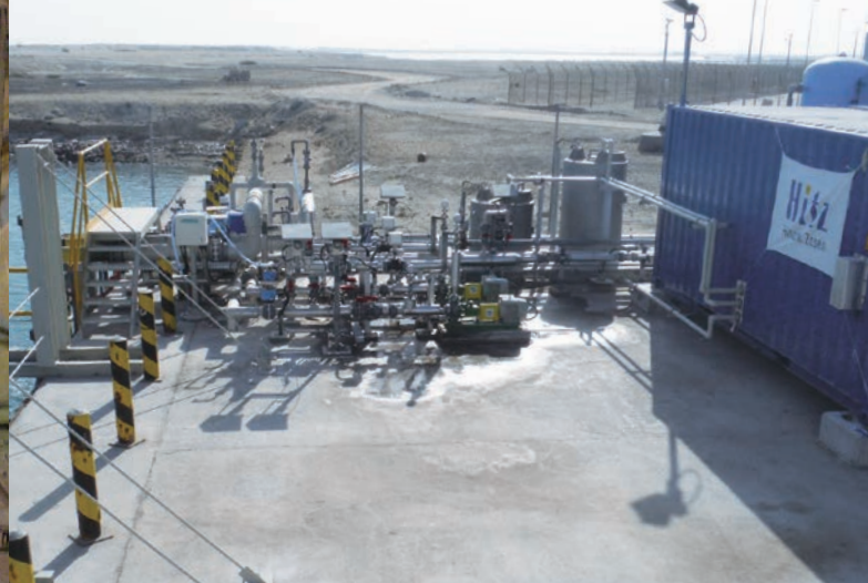
◀ 茨城工場の2号発電設備
