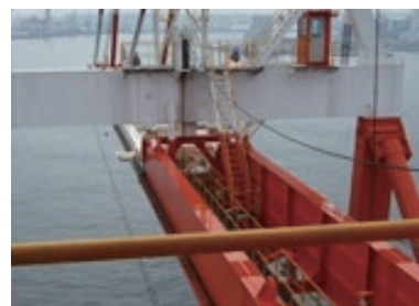
クレーン点検修理 検査・計測・診断技術及び更新や改造、メンテナンスまでトータルで提供します。
