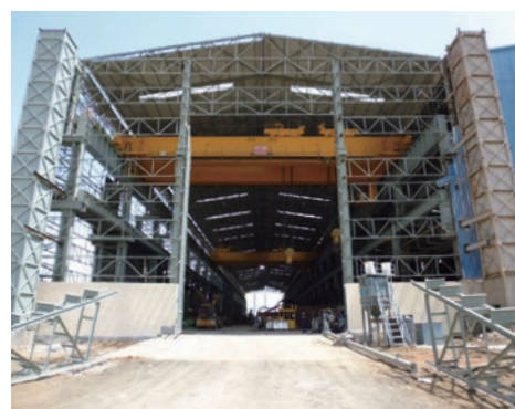
▲ ISGEC Hitachi Zosen Limitedにおいて建設中の新工場
