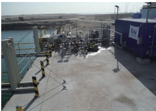
高速海底浸透取水技術を適用したパイロットプラント
