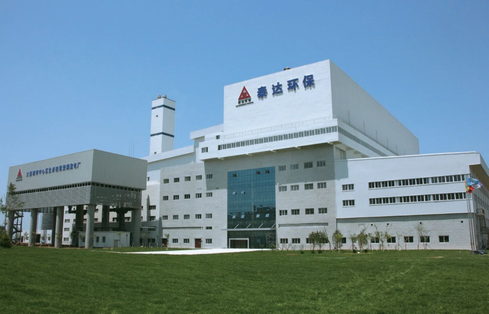
▲ 中国・大連城市中心区生活ごみ焼却発電所
