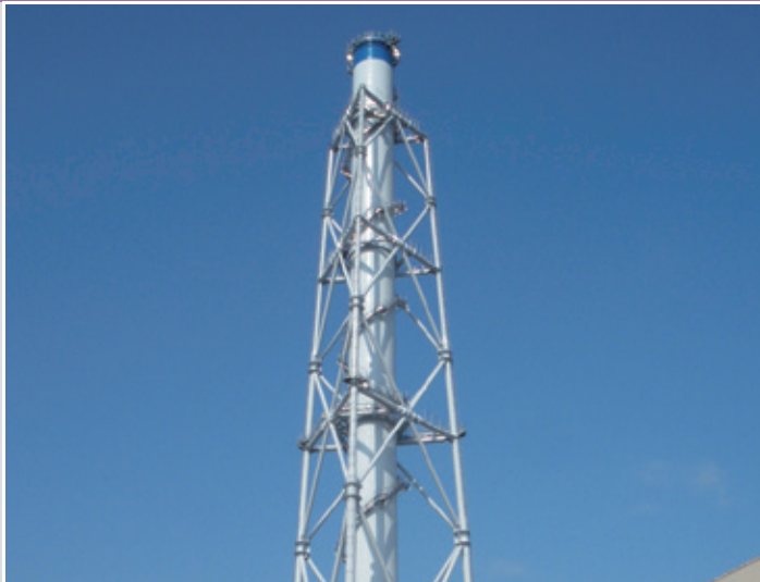
鹿島共同火力株式会社向け鋼塔煙突
