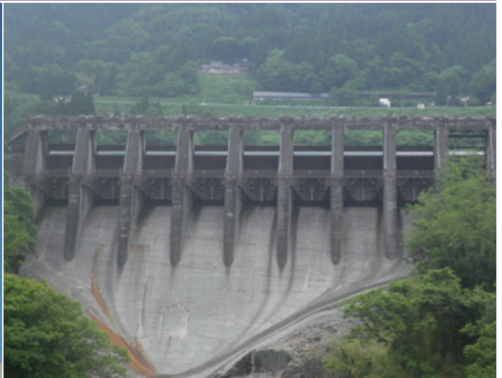
神通川第一発電所ゲート取替工事
