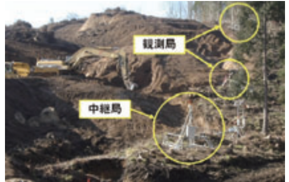
GPS精密測位斜面崩壊の監視システム
