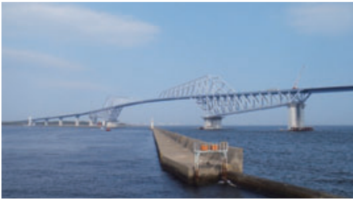
東京ゲートブリッジ
