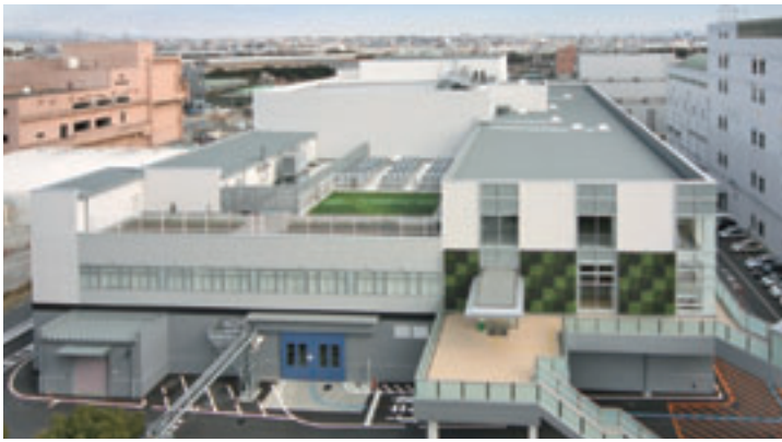
豊中市伊丹市クリーンランドリサイクルプラザ
