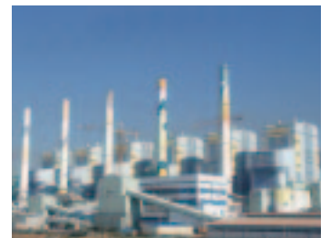
脱硝プラント
