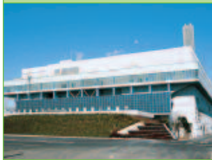
東京二十三区清掃一部事務組合 品川清掃工場
