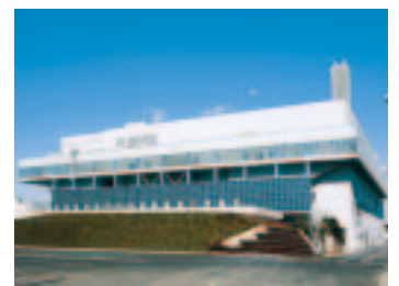
東京二十三区清掃一部事務組合 品川清掃工場
