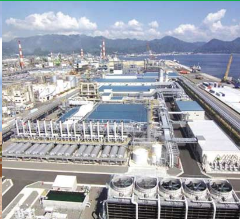
アセテート・トルエン製造プラント
