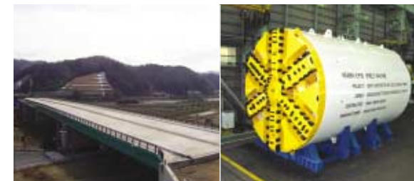
京都府向け大川橋上部工事
