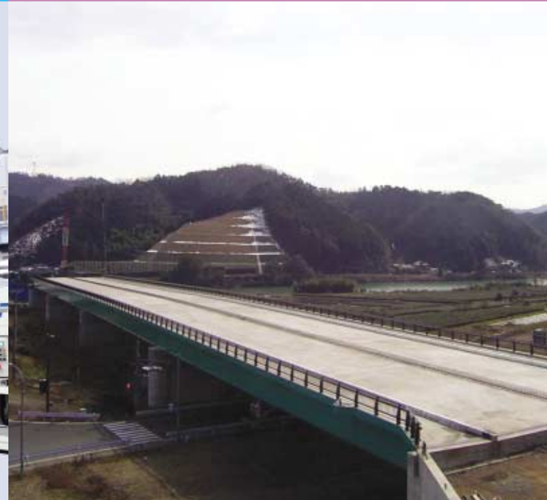
京都府向け大川橋上部工事
