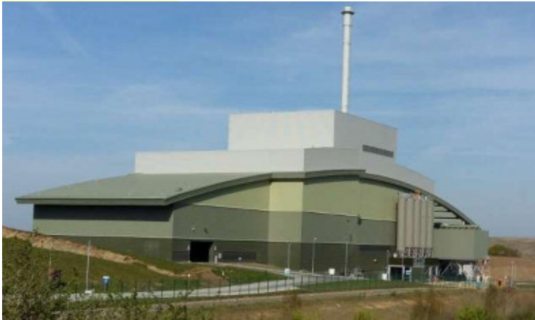
Buckinghamshire 都市ごみ焼却発電プラント (英国、ごみ処理能力:900t/日、発電出力:27,700kW)
