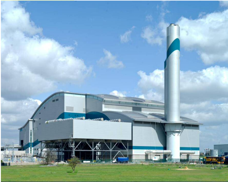
英国ロンドン・リバーサイド ごみ焼却発電施設 (2,332t/d 65MW)
