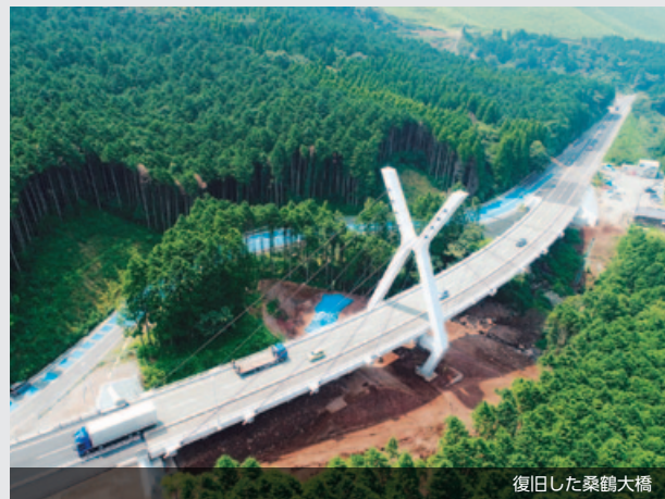
復旧した桑鶴大橋
