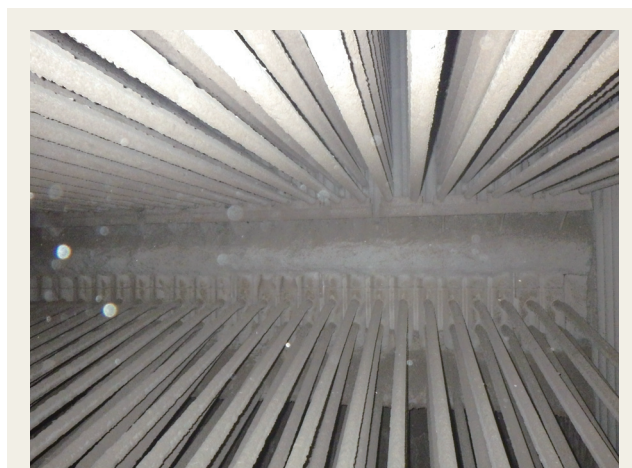
図9 除塵効果の確認（過熱器入口部）
