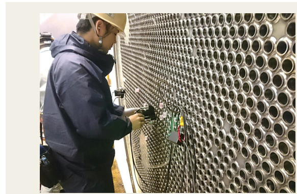
図3 実機での検査
