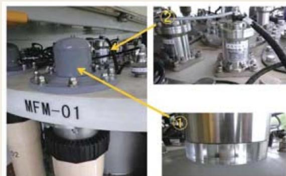
図9 ①膜損傷検出器 ②緊急遮断弁
