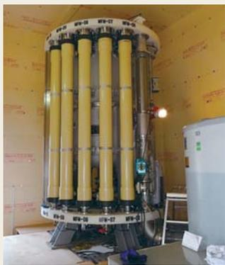
図12 C町 納入膜ろ過装置(AMF-1000S)
