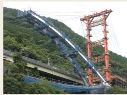
図11 上弦材架設
