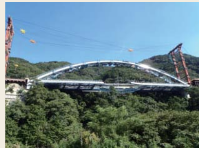
図12 下弦材架設
