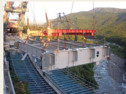
図13 床組み材架設
