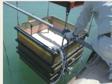
図5 HiSISユニット据付時の様子
