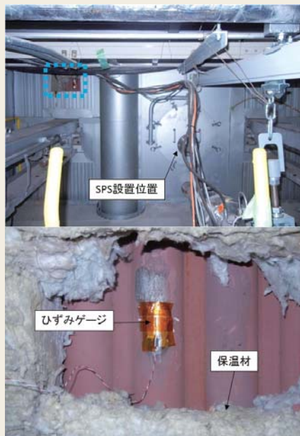
図6 ひずみゲージ設置状況
