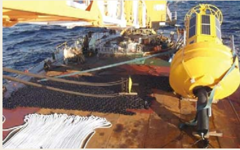
図17 設置工事の様子
