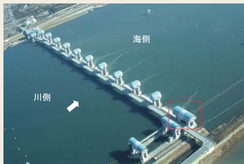
図9 長良川河口堰 下流側閘門ゲート
