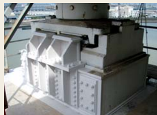
図15 支承沓座改造工 (追加移動機能の確保)
