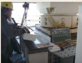
図19 ノックオフ設置
