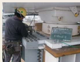
図20 サイドブロック設置
