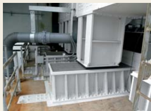
図14 落橋防止兼段差防止装置
