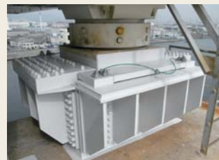
図16 支承沓座改造工 (ロックオフ構造等)
