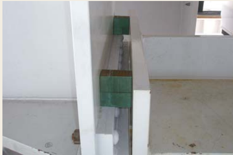
図17 間詰め材の設置状況
