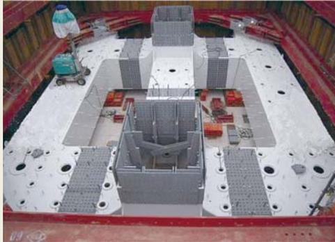
図20 単独フーチングの施工状況
