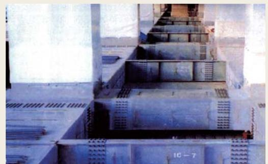
図15 鋼製直接基礎の施工状況
