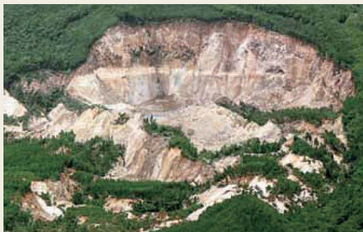
図12 施工場所崩落崖の全景
