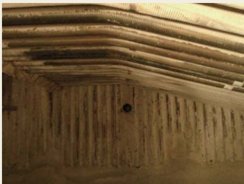
図6 肉盛溶接によるドレンカット対策
