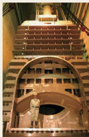
図16 摺上川ダムジェットフローゲート(下流側より見る)
