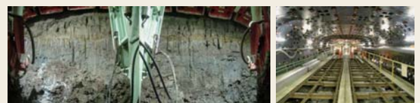
図36 切羽の掘削状況 図37 坑内状況
