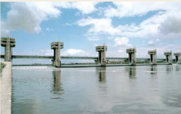
図14 淀川大堰(下流側より見る)
