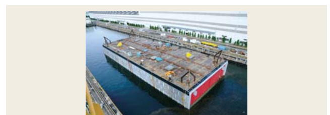
図42 沈埋函
