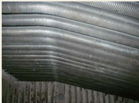
図19 スートブロウドレンカット対策 (チューブプロテクター)
