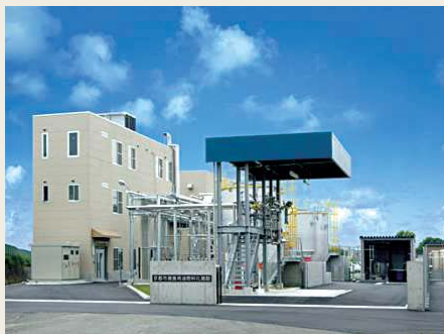
図24 BDF製造設備
