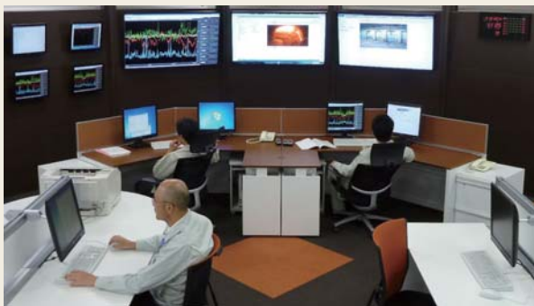
図22 遠隔監視・運転支援センター景観
