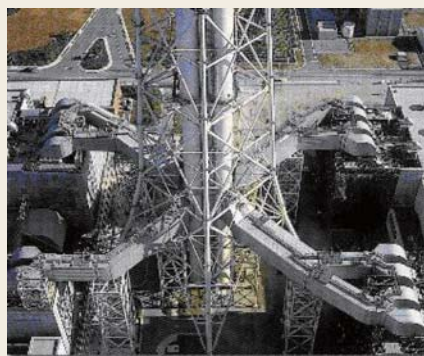
図4 東京電力 富津火力発電所 GTCC
