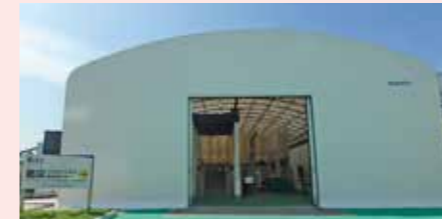
カナデビア 防災ソリューションラボラトリー 高さ7.1m×縦横50m×横幅15m Kanadevia Disaster Prevention Solution Laboratory H7.1m×D50m×W15m
