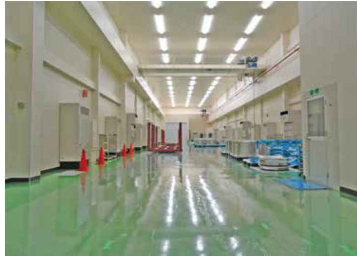
クリーンルーム (CLASS10000・作業エリア約 420m 2 ) Clean Room (CLASS10000, work area approx. 420m 2 )
