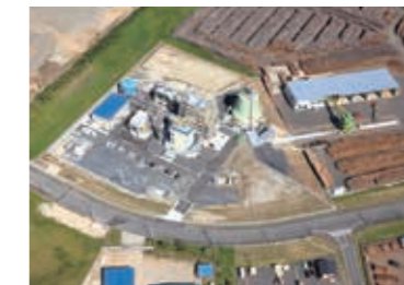
発電所に併設する燃料供給設備 Fuel skid adjoining to power station
