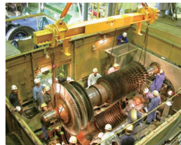
ガスタービン開放点検の様子 Overhaul of gas turbine
