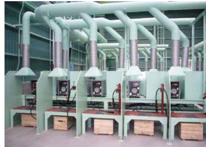
アーク溶接 Arc welding
