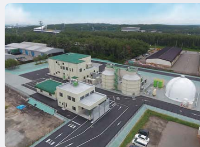
●バイオマスプラント 秋田バイオガス発電所 生ごみからメタンを発生させ、エネルギーを回収するバイオマスプラント。間伐材などの木質バイオマスから電気を生かすバイオマス発電プラントなどの設計から運転・管理までのソリューションをご提案します。
