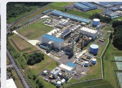
●発電プラント カナデビア茨城発電所 ガスタービン、ガスエンジン、ディーゼルエンジンなど、電力の需要にあわせて運転・制御が可能な発電設備やコージェネレーションシステムを提供しています。
