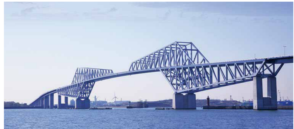
東京ゲートブリッジ Tokyo Gate Bridge
