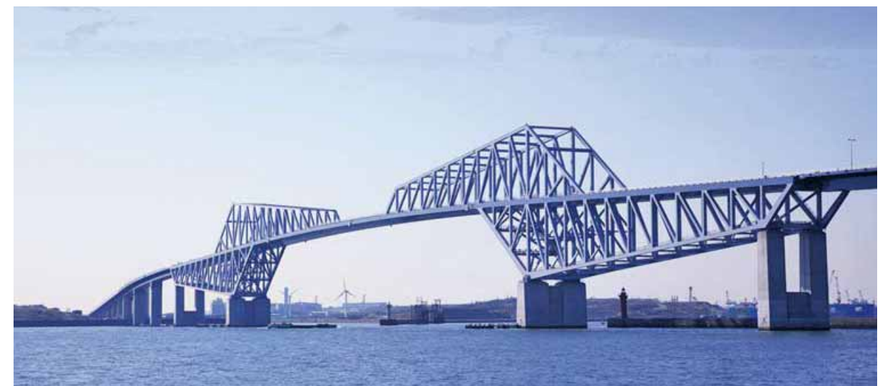
東京ゲートブリッジ Tokyo Gate Bridge
