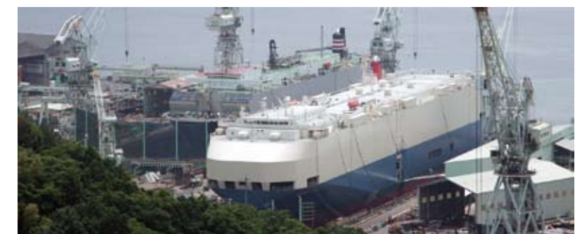
3号ドック No.3 dock
