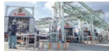
LNG荷卸しの様子 LNG unloading
