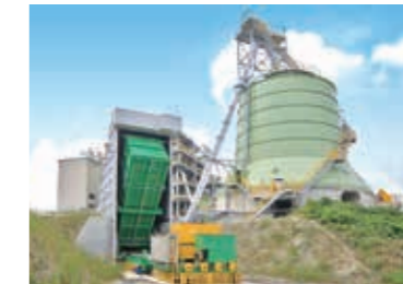
燃料受入ホッパー Fuel receiving hopper
