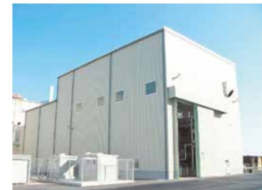
第2エンジン実験棟 No.2 Engine Lab.
