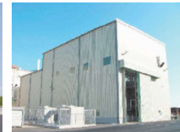
第2エンジン実験棟 No.2 Engine Lab.
