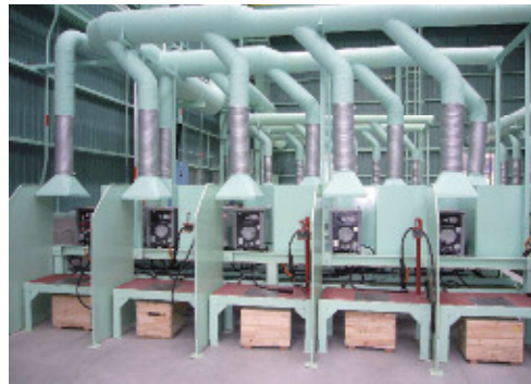
アーク溶接 Arc welding
