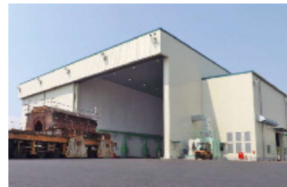
ブラスト・塗装工場 Blasting and painting workshop
